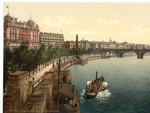
Ansicht eines der beiden großen Themseuferdämme in London. Das gegenüberliegende Albert Embankment war damals vor allem durch den Lambeth Palace und die neu errichtete London County Hall geprägt.
